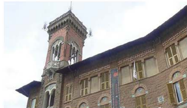
PALAZZO FASCIE chiuso per lavori
